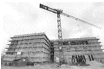
Der Rohbau der neuen Integrierten Leitstelle in Brodswinden (Stadt Ansbach) steht bereits kurz vor Fertigstellung. Ab Februar 2024 kann der Ausbau beginnen. Foto: Landratsamt Ansbach/Josephine Georgi
